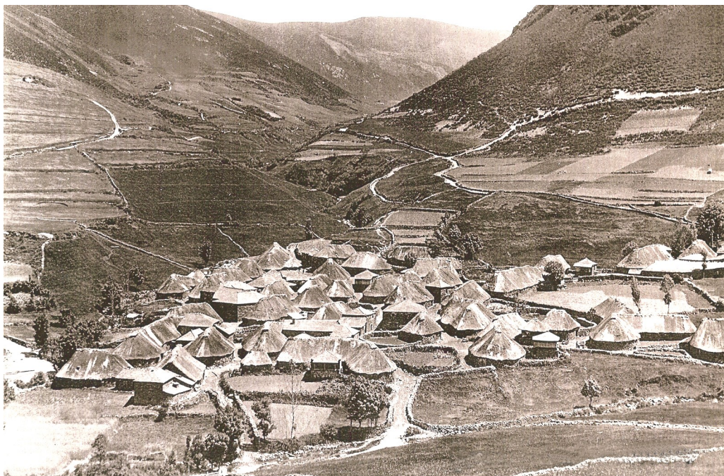
Balouta en 1915 era una aldea perdida en el corazón de los Ancares cuyas casas se encontraban cubiertas en su mayoría de palla .
