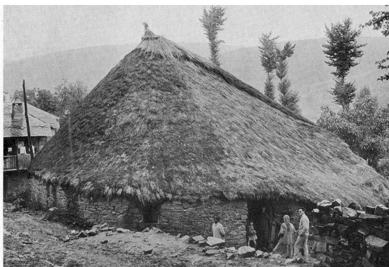
Vieja fotografía en la que observamos una casa de palla de Paradela.
